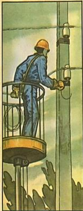
прокладку временных линий электро-снабжения
