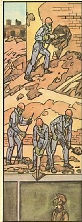
Пробивка отверстия в перекрытии убежища
