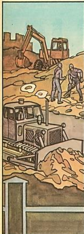
Расчистка завала основного входа
