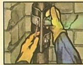
ремонт поврежденных трубопроводов
