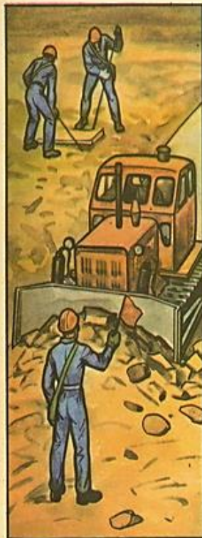
Прокладка колонных путей и устройство проездов в завалах
