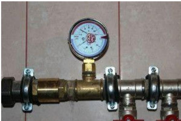
Термометр для тепловой проверки
