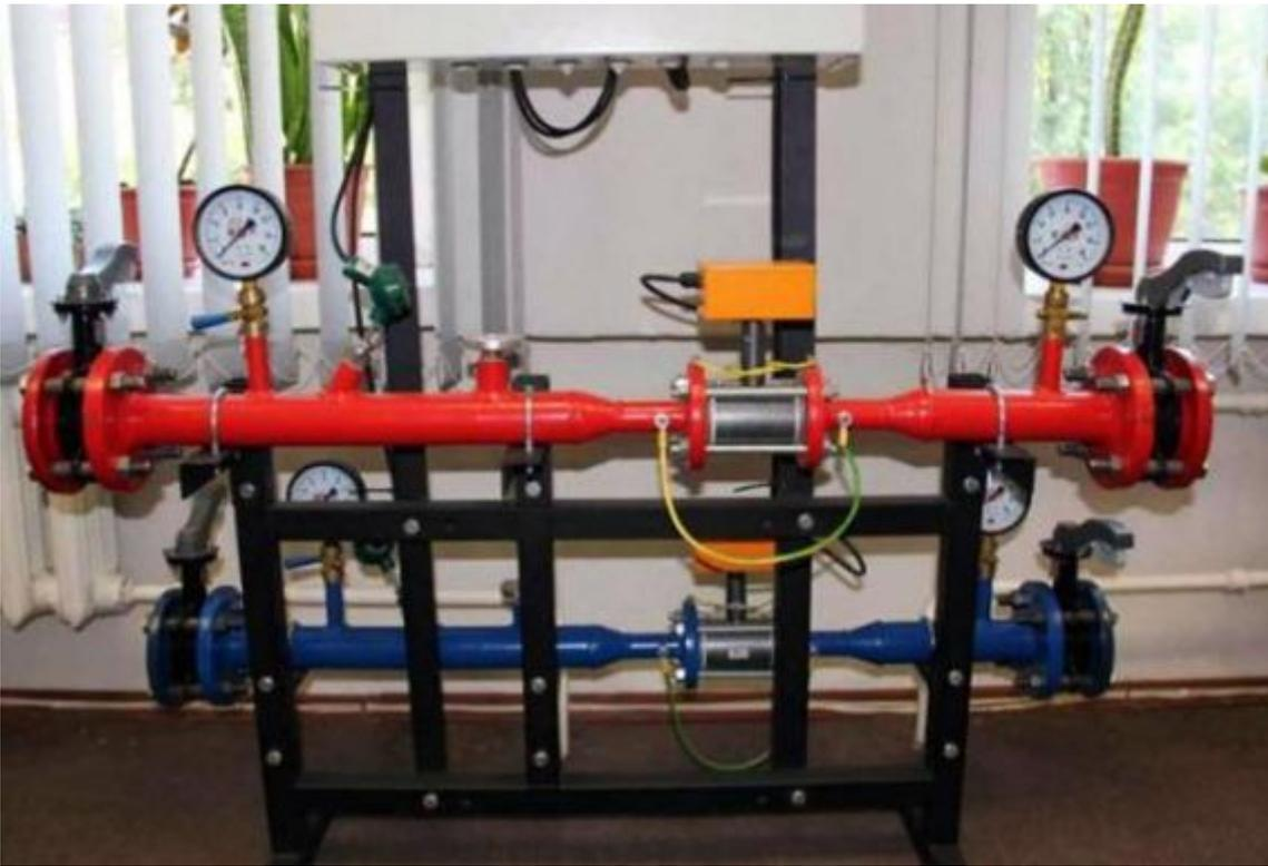
Итак, работа элеваторного узла, установленного в тепловом пункте, состоит в снижении температуры воды путем подмешивания в подающий трубопровод остывший теплоноситель из обратки. Следует отметить, что данный элемент считается устаревшим, хотя до сих пор повсеместно используется. Сейчас при устройстве тепловых пунктов применяются смешивающие узлы с трехходовыми клапанами либо пластинчатые теплообменники.
